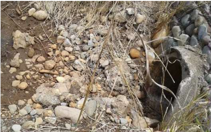
Adecuación de drenajes
