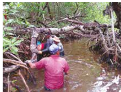
Figura 24. Fotografías del proceso de desazolvamiento de un canal principal.
